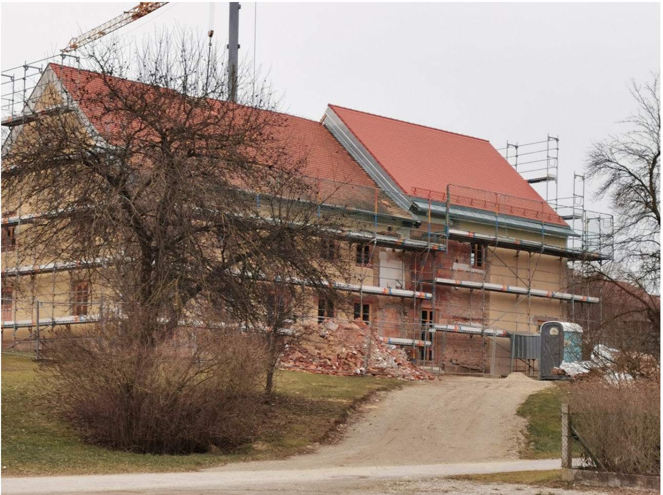
Foto: Baufortschritt am Schulhaus Hinterskirchen
