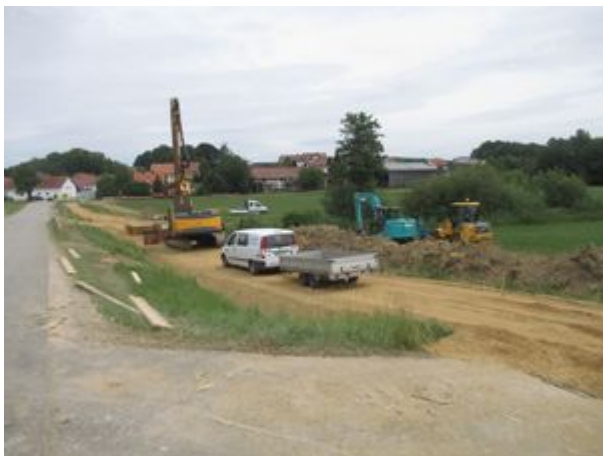
Bau des neuen Geh- und Radwegs zwischen Neufraunhofen und Hinterskirchen.
