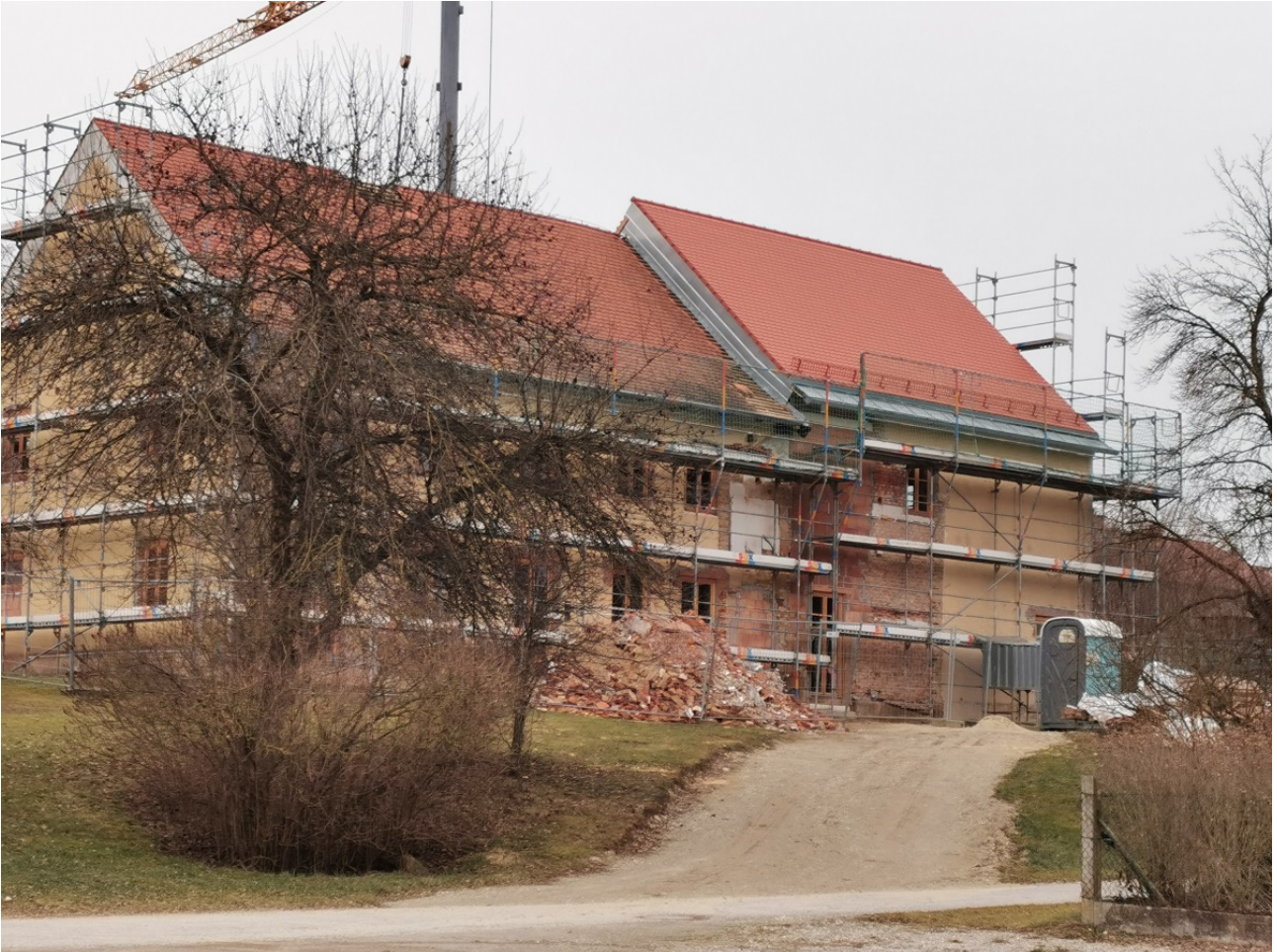
Foto: Baufortschritt am Schulhaus Hinterskirchen
