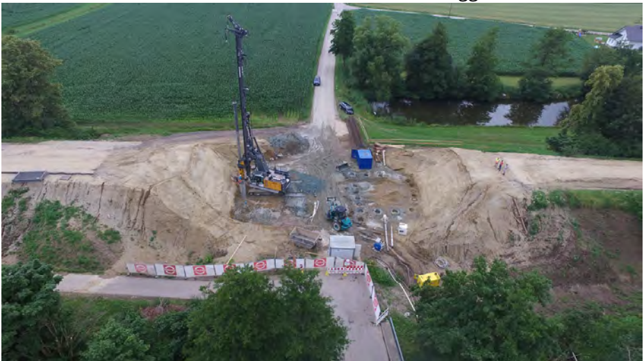
Foto: Brücke Ruprechtsberg - Staatliches Bauamt Landshut
